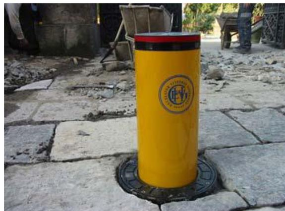
Schließen Sie den Einbau durch Erstellen der Oberfläche ab. Testen Sie den Poller.
