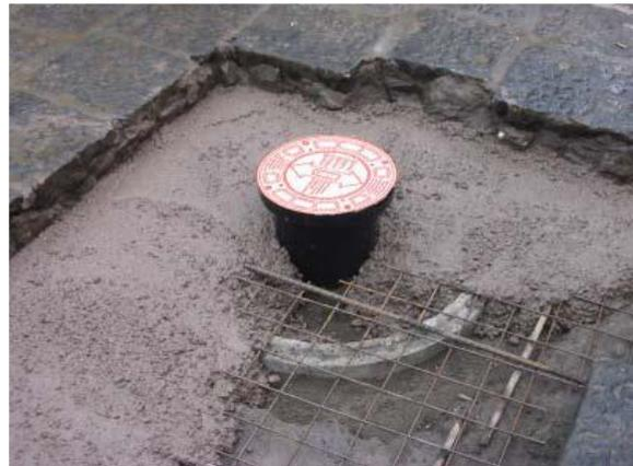
Verfüllen Sie das vorgefertigte Zementrohr mit Sand und richten die Zuleitung entsprechend aus. Verlegen Sie die Baumstahlmatten und füllen Sie diese mit Beton auf.
