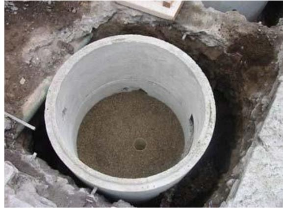
Bereiten Sie den Boden und die Einbauhöhe mit Sand vor.
